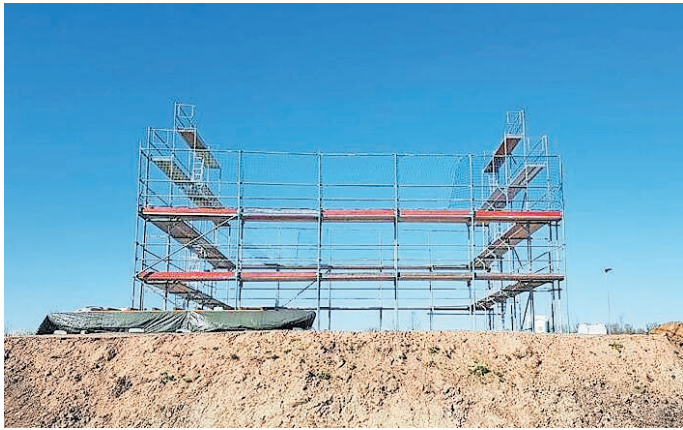
Erst das Gerüst ....
